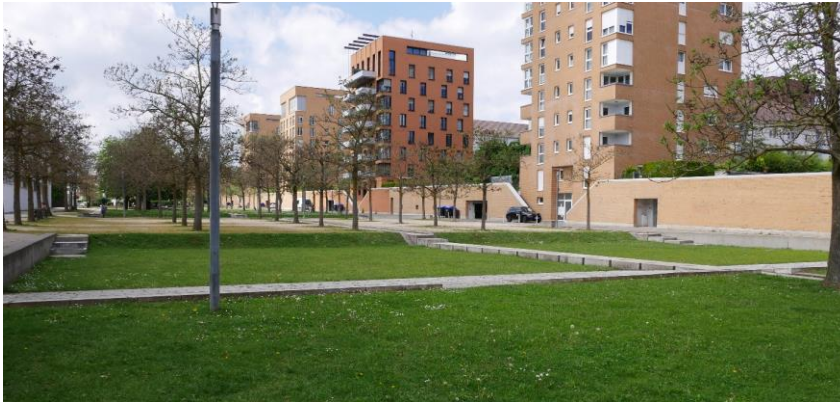
Retentionsräume, Scharnhäuser Park
