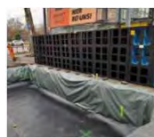
Quelle: Stadtentwässerung Stadt Frankfurt
